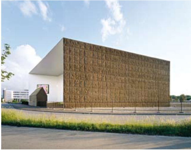
Das Schaulager von aussen
